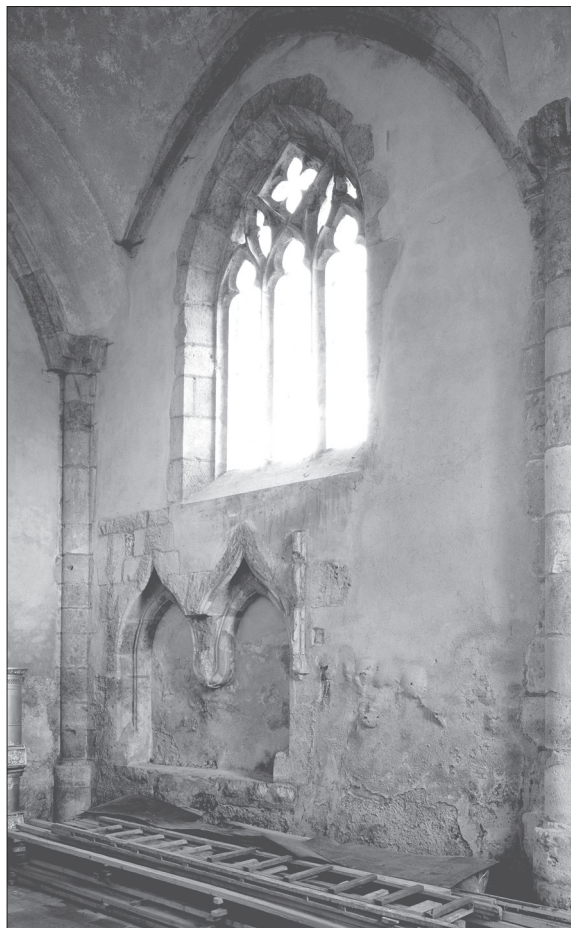
Obr. 4. Plešivec, Reformovaný kostol, severná stena tzv. Bebekovskej kaplnky v úseku západného klenbového poľa. Foto P. Breier, archív ÚDÚ SAV. Abb. 4. Plešivec, Reformierte Kirche, Nordwand der sog. Kapelle der Adelsfamilie Bebek im Abschnitt des westlichen Gewölbefeldes. Foto P. Breier, Archiv – Institut für Kunstgeschichte, Slow. Akademie d. Wiss.
