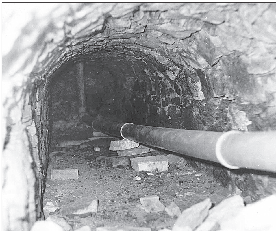
Obr. 6. Cheb, hrad, barokní odvodňovací žlábek a kanál pod prachárnou.
