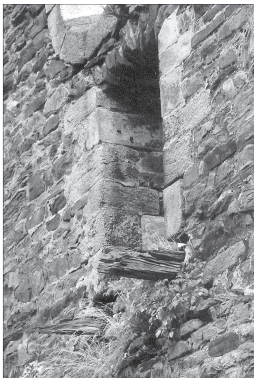
Obr. 3. Cheb, hrad, prevět u komnaty paláce s dřevěnými nosníky, 12. století.
