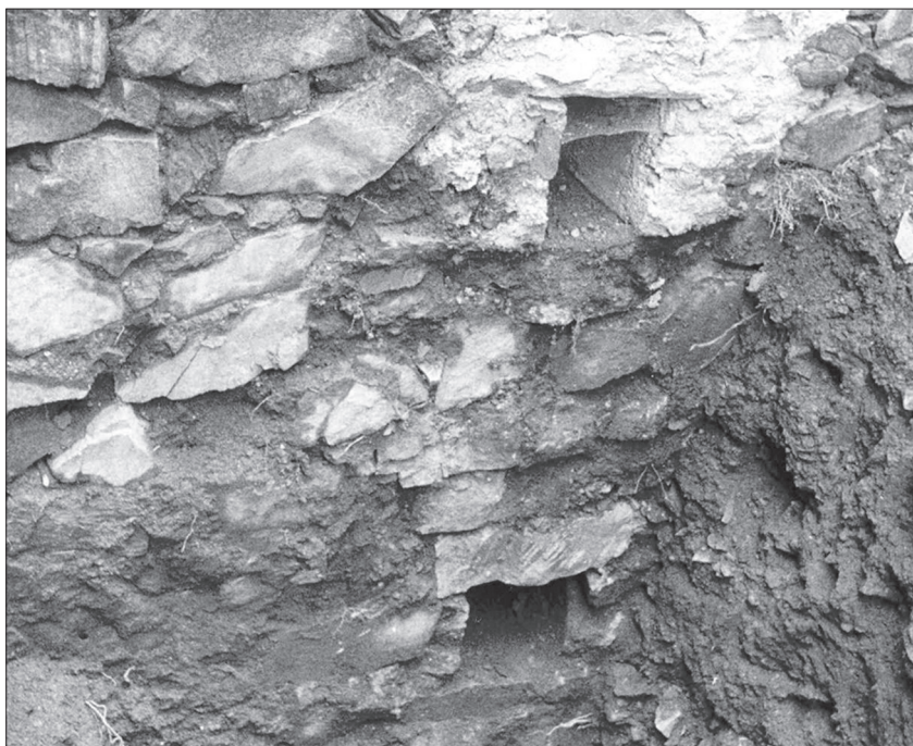
Obr. 5. Cheb, hrad, gotický a barokní odvod dešťové vody skrz východní hradbu.
