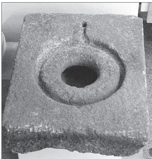
Obr. 8. Cheb, hrad, zděné topeniště s uzavíratelným kamenným dýmníkem.
