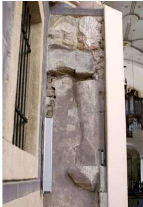
Obr. 6. Bratislava, františkánsky kostol, detail nálezu staršieho muriva (murivo „A“ na obr. 2) s kútovou konzolou, nábehom klenbového rebra a fragmentom maľovaného konsekračného križa. Foto B. Pomfyová.
