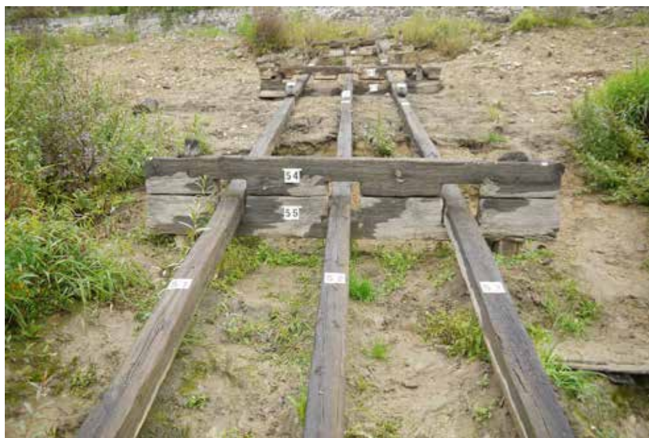
Obr. 6. Tábor – Jordán. Jižní spodní výpusť – tři svahová táhla procházela otvory v dřevěných lavicích, jež byly umístěny v několikametrových odstupech na svah návodní strany hráze mezi její korunou a převodovým mechanismem na spodním konci táhel.
