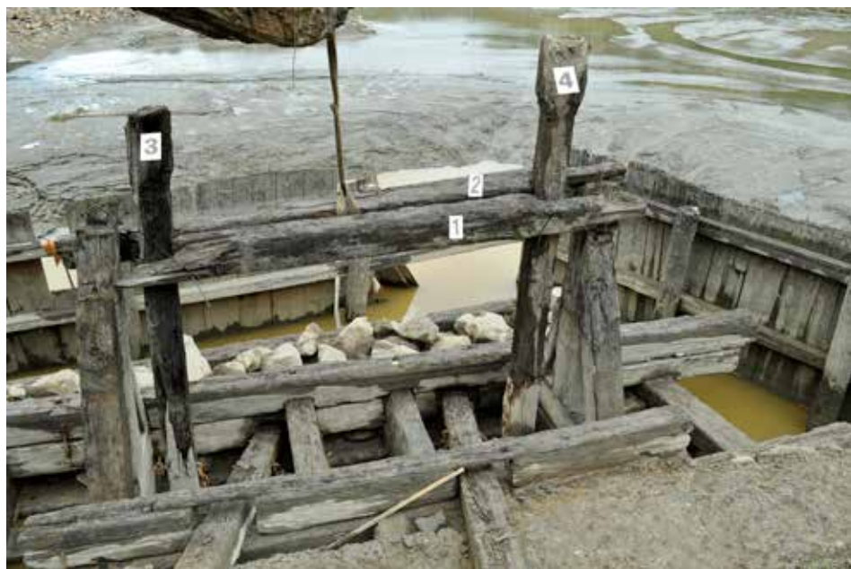
Obr. 14. Tábor – Jordán. Severní spodní výpust' – na rámovou konstrukci s převodovým bubnovým mechanismem byla nahoře postavena dřevěná lavice na vedení svislých čapů (č. 3 a 4).
