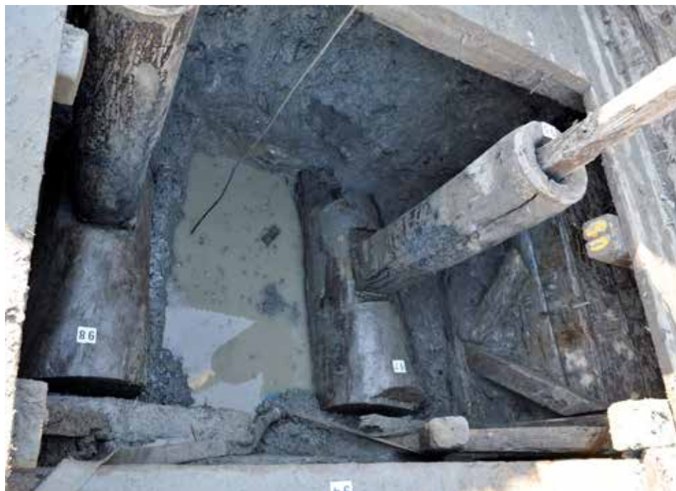
Obr. 16. Tábor – Jordán. Severní spodní výpusť – svislé vrtané roury (č. 95 a č. 96), které byly uzavírány čapy, dosedaly dole na otvory v horní ploše vodorovných výpusťných rour (č. 97 a 98). Vpravo je patrná vydřevená stěna spodní komory. Abb. 16. Tabor – Jordan-Stausee. Nördlicher unterer Ablass – die senkrechten durchbohrten Röhre (Nr. 95 und Nr. 96), die mit Zapfen geschlossen wurden, saßen unten auf den Öffnungen in der oberen Fläche der waagerechten Ablassrohre auf. (Nr. 97 und 98). Rechts ist die ausgezimmerte Wand der unteren Kammer zu sehen.
