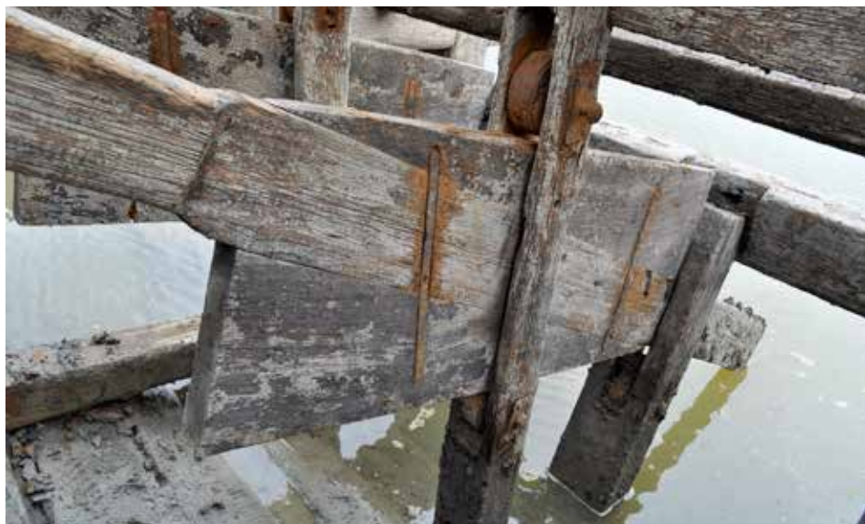
Obr. 7. Tábor – Jordán. Jižní spodní výpust' – speciálně tvarované spodní konce táhel s fošnami do obdélníku, který prochází otvorem ve svislém čapu. Pohybem dopředu a dozadu docházelo díky tomuto rozšíření na spodním konci táhel (tzv. nůžky) ke zvedání nebo klesání čapu, jehož spodní konec uzavíral nebo otevíral čapové oko ve výpustné rouře.
