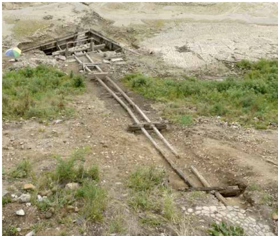
Obr. 17. Tábor – Jordán. Severní spodní výpusť – celkový pohled na dřevěné konstrukce se svahovými táhly a rámem pro čapové ovládání dvou výpustných rour a směrem k vodě s předsazenou kompaktní dřevěnou stěnou. Abb. 17. Tabor – Jordan-Stausee. Nördlicher unterer Ablass – Gesamtansicht der Holzkonstruktion mit Böschungszugstangen und dem Gestell für die Zapfenbedienung der zwei Ablassrohre und der in Wasserrichtung vorgesetzten kompakten Holzwand.
