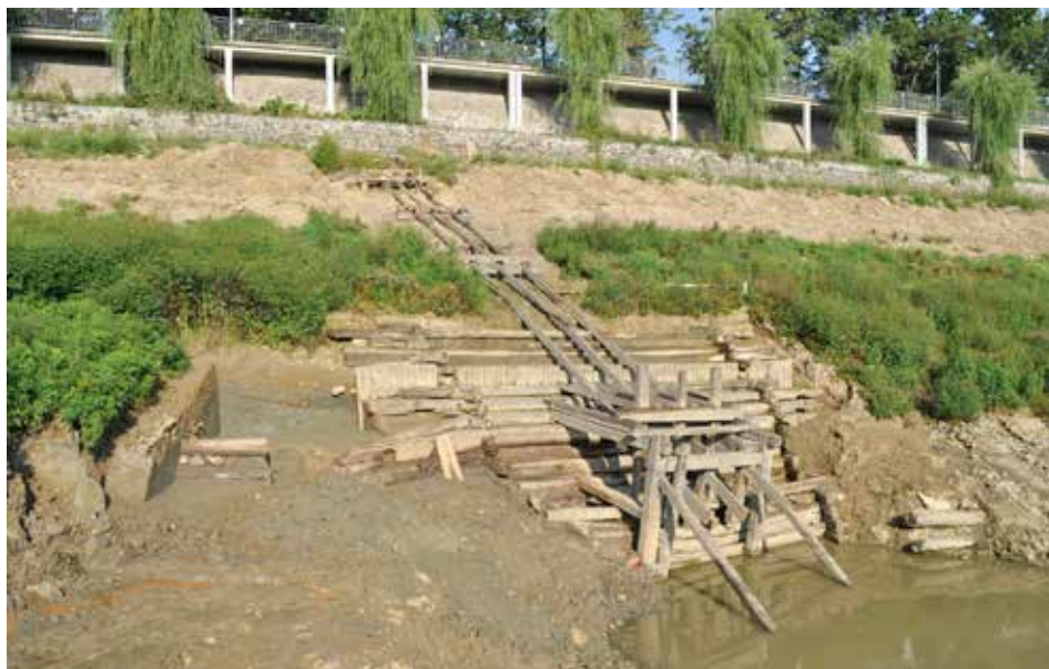
Obr. 9. Tábor – Jordán. Jižní spodní výpust – celkový pohled na dřevěné konstrukce se svahovými táhly a rámem pro časové ovládání výpustných rour včetně zpevnění návodní strany hráze kolem nich kompaktní schodovitou dřevěnou stěnou. Vpravo a vlevo od soustavy jsou patrné vodorovně položené kmeny, které zpevňovaly patu návodní strany hráze.
