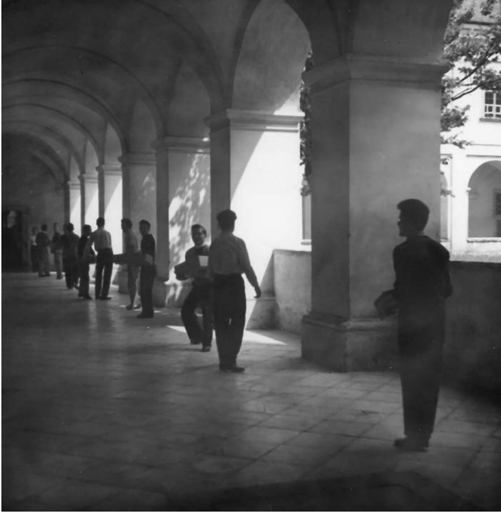
Abb. 2: Die Übersiedlung der Archivalien in die neuen Räumlichkeiten im Obergeschoss des Kreuzgang-Westtraktes (Foto: DASP).
