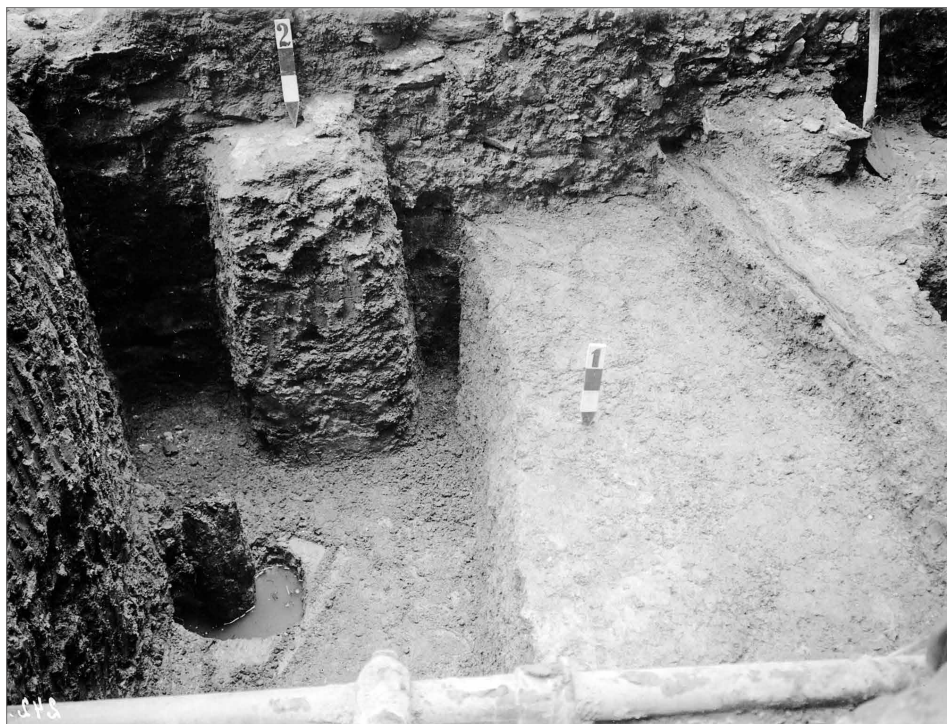
Obr. 17. Pražský hrad, 3. nádvoří. Rozebírání svrchní části mladšího hradebního tělesa před vstupem do tehdejšího ministerstva zahraničí s odkrytými horizontálními i vertikálními dřevěnými prvky. Pohled od západu, foto J. Pasternak, 29. září 1926. Zdroj ARÚ Praha, pozůstalost I. Borkovského, FT000103242.
