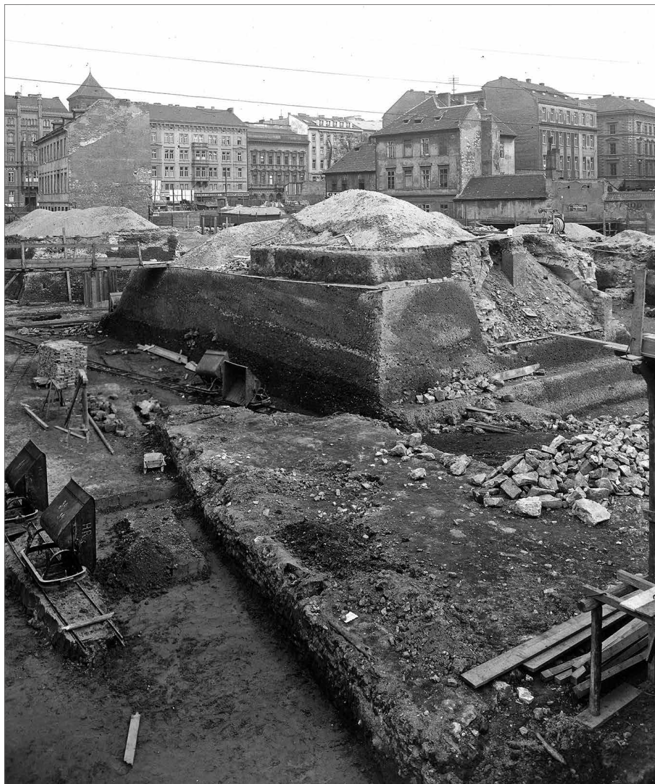
Obr. 21. Praha 1, Na Františku. Dokumentace staroměstského opevnění na staveništi budovy tehdejšího ministerstva průmyslu, obchodu a živnosti, 17. 5. 1928. Památkový sbor, A4186B. Zdroj ARÚ Praha, pozůstalost I. Borkovského.
