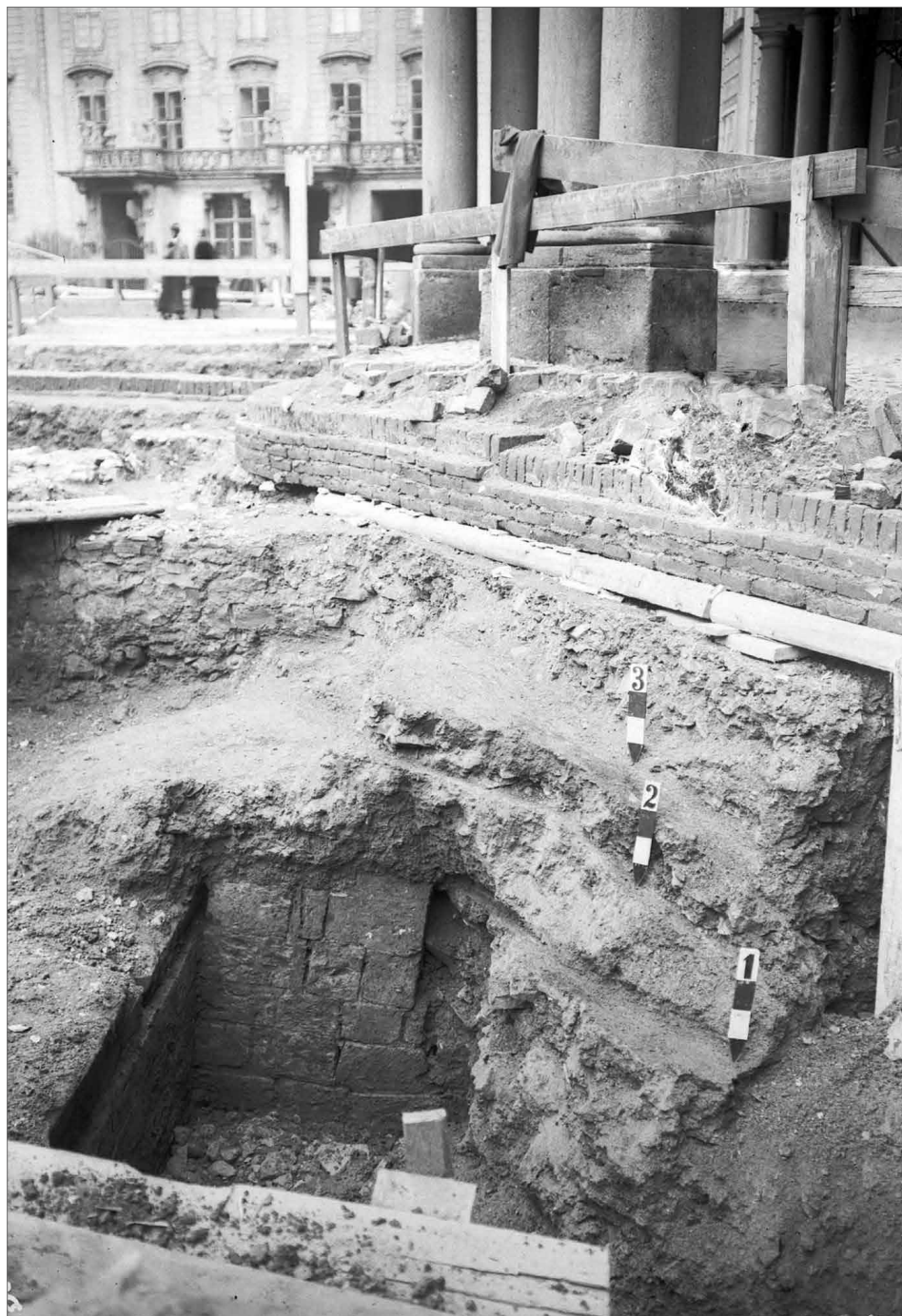
Obr. 16. Pražský hrad, 3. nádvoří, 29. září 1926. „Třetí hluboká sonda na povrchu valu před portálem F. III.“ Příklad postupného odkryvu terénu za vedení J. Pasternaka, foto J. Pasternak. Zdroj ARÚ Praha, FT000103256.
