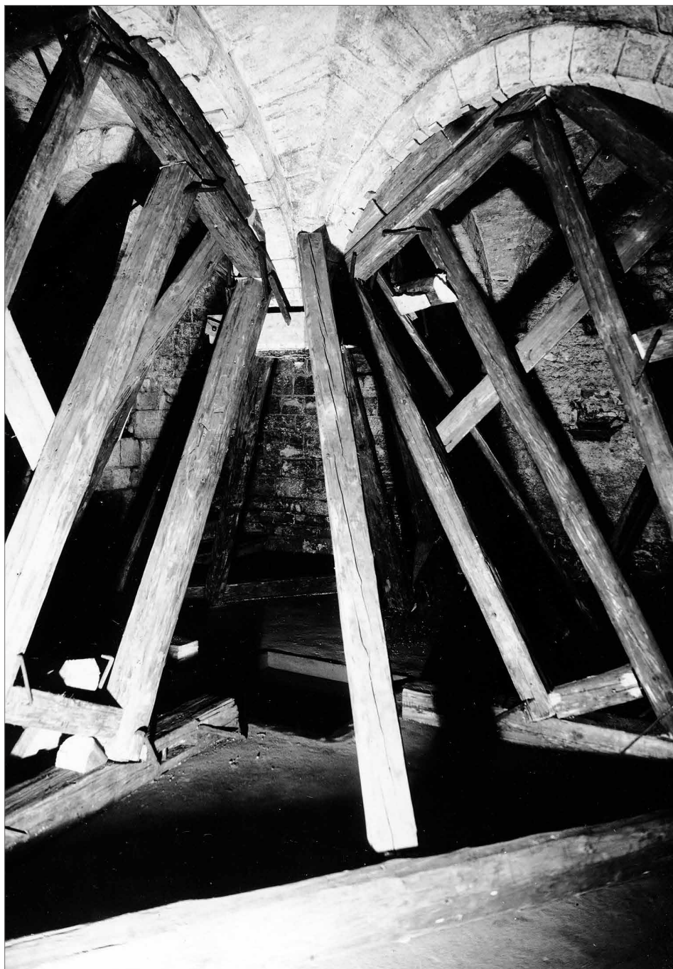
Obr. 7. Praha 1, Staré Město, Kaprova – Platněřská, někdejší suterény zaniklého čp. 16. Ukázka lešení postaveného B. Kabátem po odstranění původního poškozeného románského sloupu před instalaci jeho repliky. Památkový sbor, 12447A, 3. 11. 1938. Zdroj ARÚ Praha, pozůstalost I. Borkovského.
