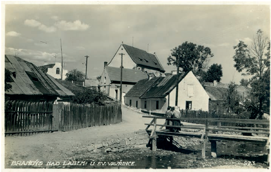
Obr. 4: Lávka přes Vinořský potok v dnešní ulici Na Strouze v Brandýse nad Labem za první republiky. Už přes půl století je potok sveden do podzemí a místo něho je vidět pouze vyasfaltovaná plocha. (Oblastní muzeum Praha-východ, inv. č. DOK 97)
