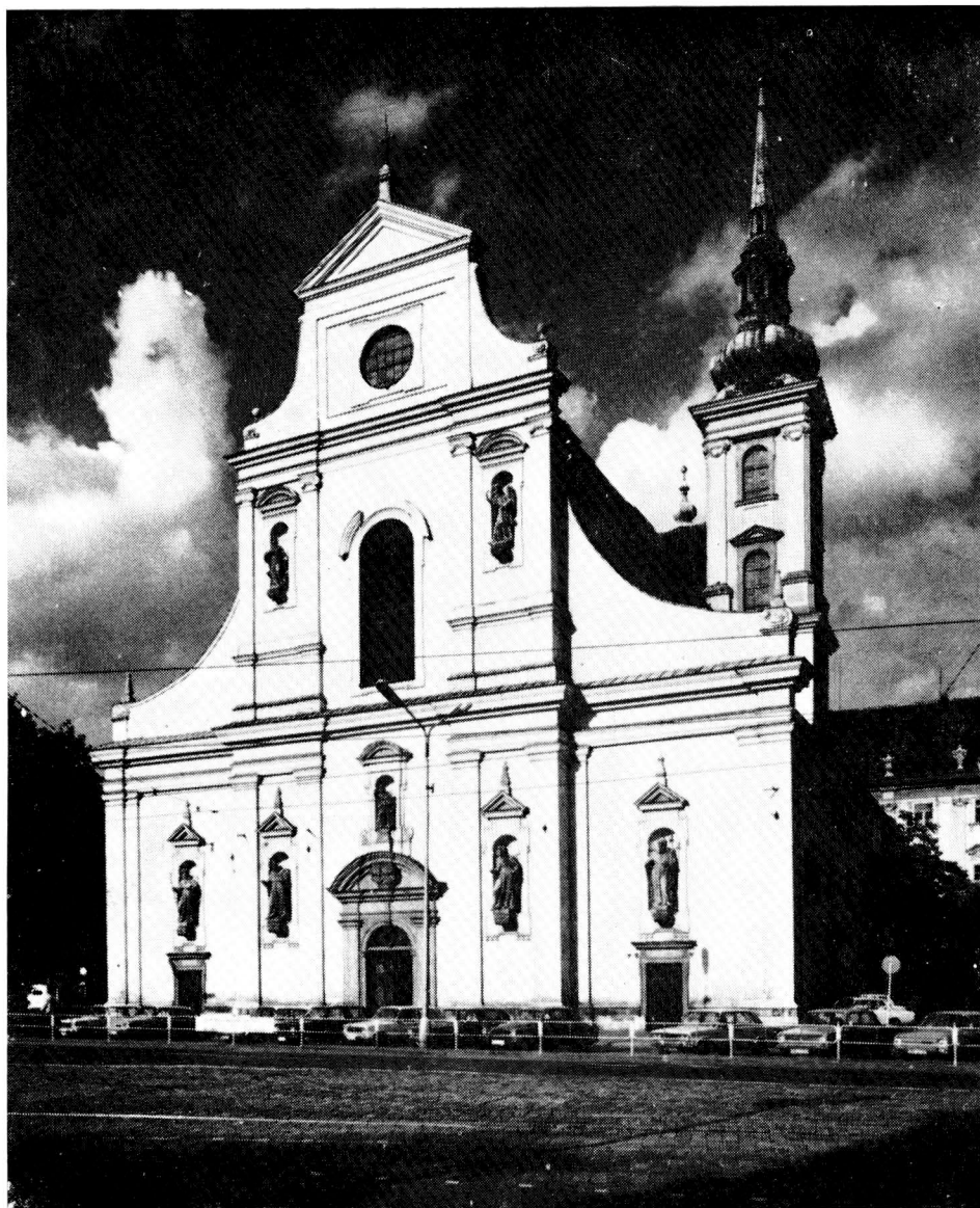
28. J. K. Erna, Kostel sv. Tomáše v Brně, hlavní průčelí, kolem 1670.
