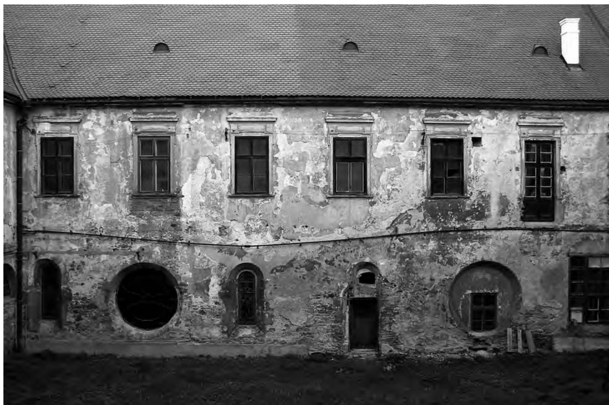
7 – Západní strana nádvoří Deskového dvora. Předklášteří, klášter Porta coeli
