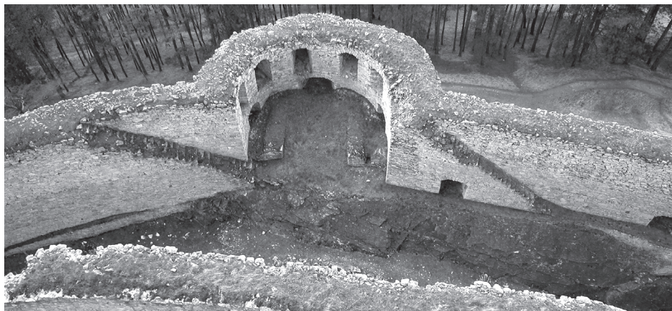
Obr. 9. Hrad Rabí, okr. Klatovy. Pohled do vnitřního příkopu v západní části hradu od východu z obytné věže. Na kontreskarpu příkopu, tesanou ve skále, navazuje hradba s baštami z počátku 16. století. Foto autor, 2004.
