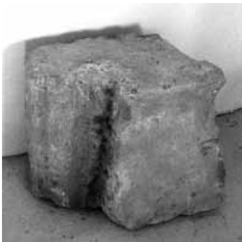
Obr. 7. Část ostění vstupu do budovy č. 1. Abb. 7. Teil der Laibung des Eingangs in Gebäude Nr. 1.
