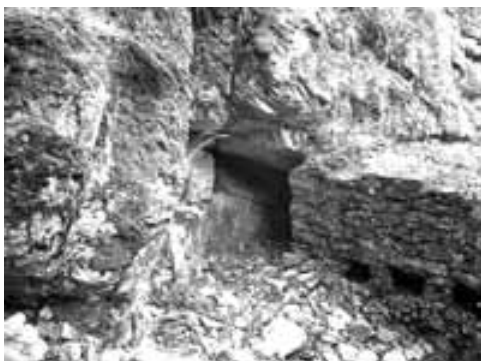
Obr. 6. Jižní část západní stěny s trámovými lůžky prvního patra a střílnou. Pohled od severovýchodu. Abb. 6. Südteil der Westwand mit Balkenlager des ersten Stockwerks mit Schießcharte. Blick von Nordosten.
