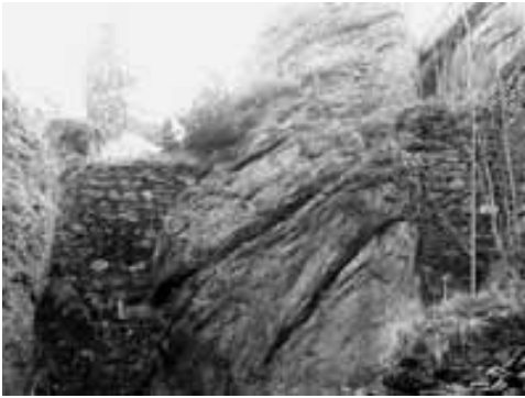
Obr. 3. Východní stěna budovy č. 1 se dvěma vyzdívkami. Pohled od západu.
