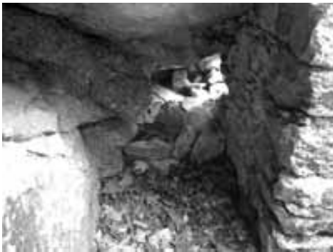
Obr. 12. Prostor střilny vysekaný ve skále za jižním okrajem západní zdi. Pohled od východu.
