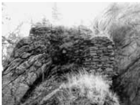
Obr. 15. Situace tří zdí na skalním masivu severně od budovy č. 1. Pohled od západu. Abb. 15. Lage der drei Mauern am Felsenmassiv nördlich von Gebäude Nr. 1. Blick von Westen.
