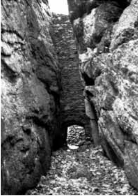
Obr. 1. Přezděná skalní soutěska s brankou do budovy č. 1. Pohled od východu.
