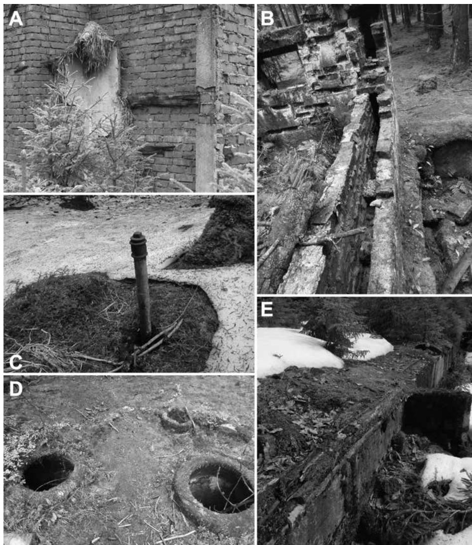
Obr. 6. Zachovalé technické detaily. A – zateplení stěn staveb (obj. 36); B – zdvojená zeď sprch (obj. 19); C – přípojka vodovodního potrubí (obj. 9); D – kanalizační šachty v nároží pochozí plochy (obj. 109; 110); E – zbytky dřevěné konstrukce stěny (obj. 50). Foto J. Hasil, 2013–2014.
