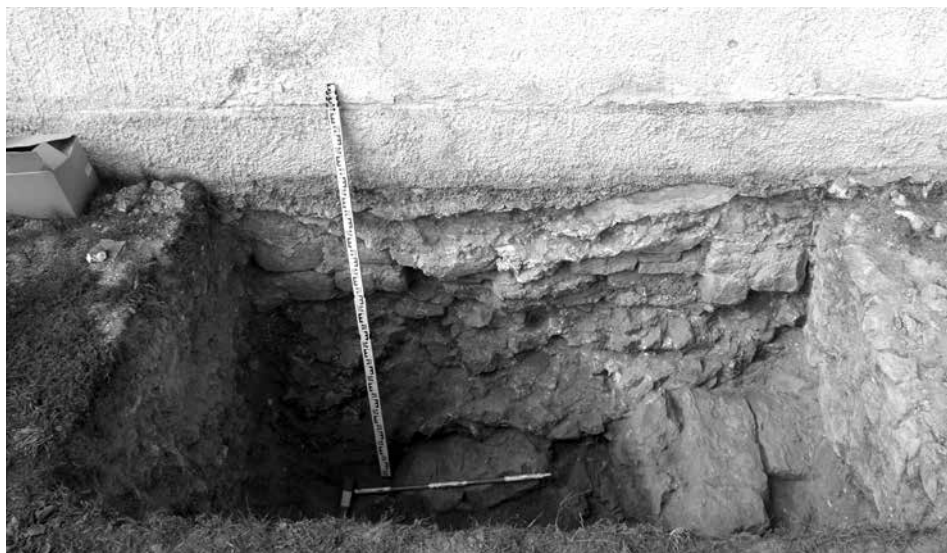
Obr. 10. Zemplín, reformovaný kostol. Sonda S7/14, základové murivo románskeho kostola a tzv. babinca stojace na skalnom geologickom podloží v miestach prerazeného gotického vstupu do kostola. Foto A. Balogh. Abb. 10. Zemplín, reformierte Kirche. Sondierschnitt S7/14, Grundmauer der romanischen Kirche und des am durchbrochenen gotischen Eingang zur Kirche auf einer Felssohle stehenden sog. „Babinec“ (Frauen vorbehaltener Raum). Foto A. Balogh.
