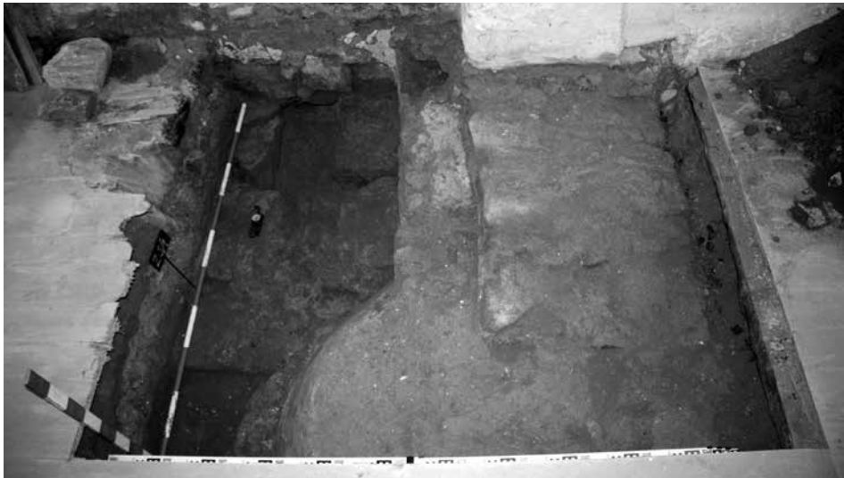
Obr. 6. Zemplín, reformovaný kostol. Sonda S1/13, základové murivo víťazného oblúka neskorogotického presbytéria a barokovej kazateľnice stojace na základoch apsidy románskeho kostola. Foto A. Balogh. Abb. 6. Zemplín, reformierte Kirche. Sondierschnitt S1/13, Grundmauer des Triumphbogens des spätgotischen Chorraums und der auf den Fundamenten der Apsis der romanischen Kirche stehenden barocken Kanzel. Foto A. Balogh.
