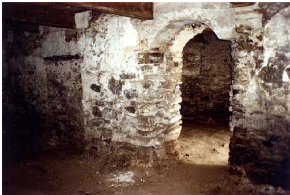
Obr. 16. Pohled od jihovýchodu na boční vstup ve spojovací příčce. Foto B. Nechvátal.
