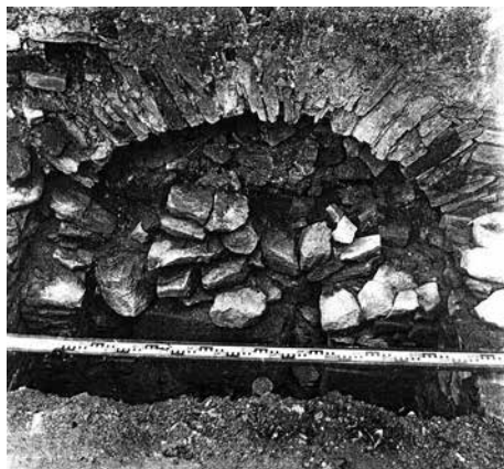
Obr. 10. Zасыpaný vchod a záklenuk do severní části O-1 (johanitská kurie) odkrytý výzkumem v roce 1963, pohled od severu. Foto B. Nechvátal.
