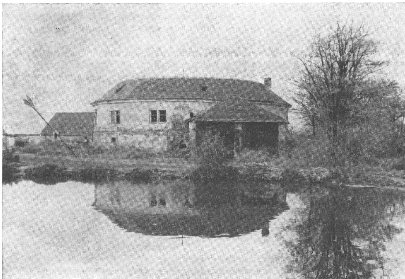
Obr. 2. Praha IV – Chodov. Stavba zámečku – přestavěné tvrze od jihozápadu. Foto Fr. Čáp.
