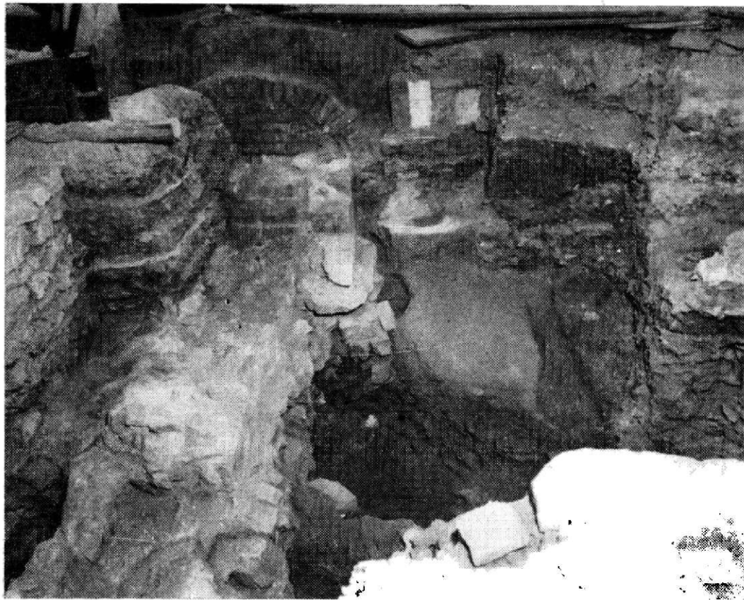
Obr. 2. Praha 1—Nové Město, sv. Kliment. Základová rýha pro absidu předrománského kostela od východu. Foto Fr. Čáp.
