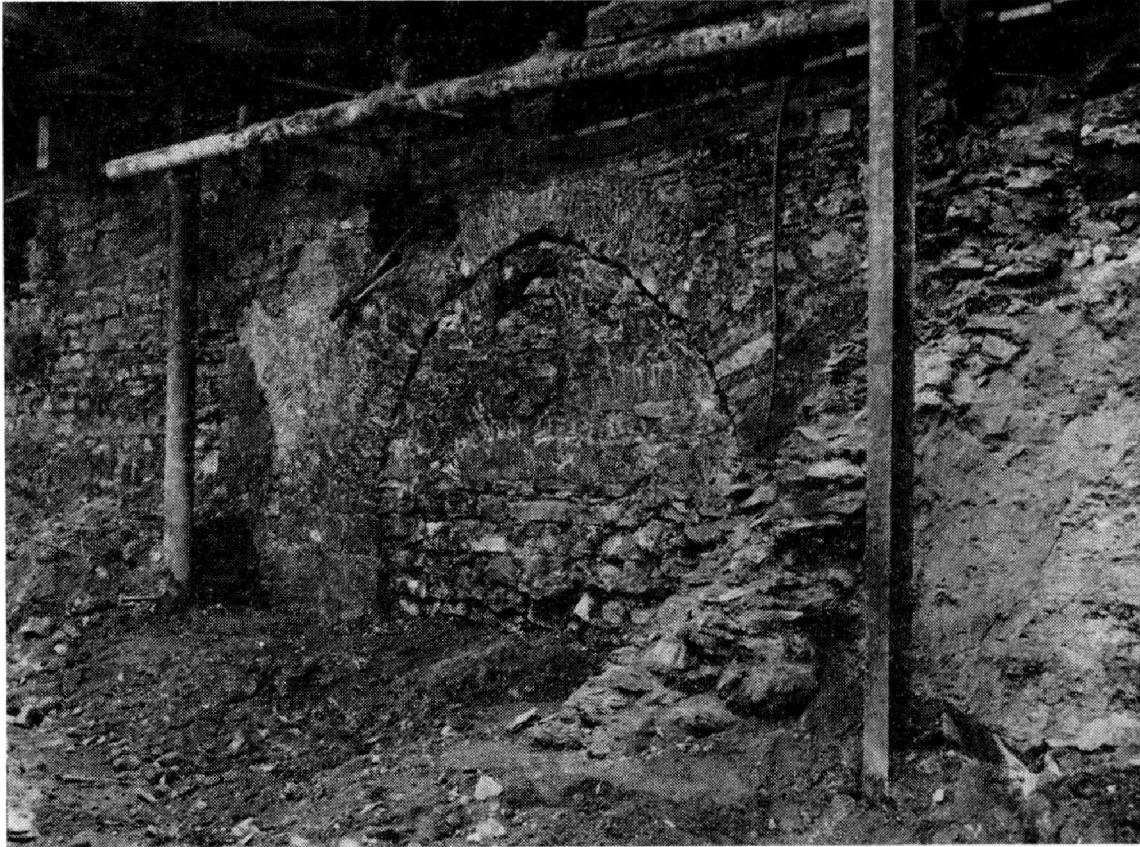
Obr. 2. Čelo kamenného mostku přes polozасыpaný příkop. Celkový pohled na stav po obnažení. V pravém dolním rohu maninská štěrkopísková terasa, vlevo od ní pískové vyklínění a dále vlevo řez břidlicovou opěrnou zdí příkopu. Ve středu snímku plně zachovaný oblouk mostního čela a pilíř mostku se zbytky omítky. V lici čela mostku dosud patrná zazdivka sklepního prostoru. Pod vrcholem oblouku sonda do zazdivky sklepního vhozu. Památka bude prezentována bez zazdivky sklepního prostoru, za kterou bude viditelná základová zeď domu čp. 380. Foto Z. Helfert.
