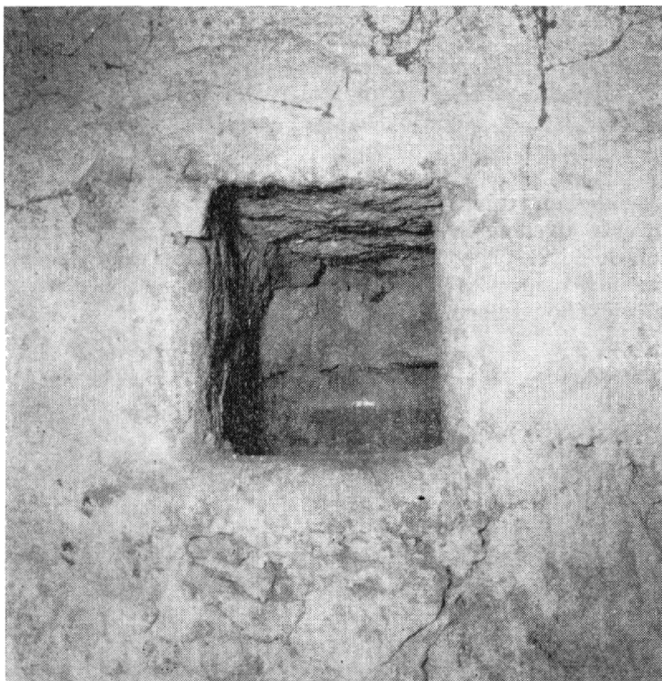
Obr. 8. Vochov (okr. Plzeň-sever), čp. 10. Pohled do ústí skříže ve zdivu sýpky po vyjmutí uzavíracího kamene. V dolní části otvoru patrné hrdlo svisle zapuštěného, uvnitř hnědě glazovaného hrnce. (Foto a kresby J. Škabrada). Za upozornění na skříž děkujeme VI. Švábkovi.
