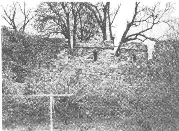
Obr. 13. Hlavní hradba východně od Pražské brány, pohled z městské strany. Úsek zřejmě nepatřící přemyslovské výstavbě. Foto autor (1985).
