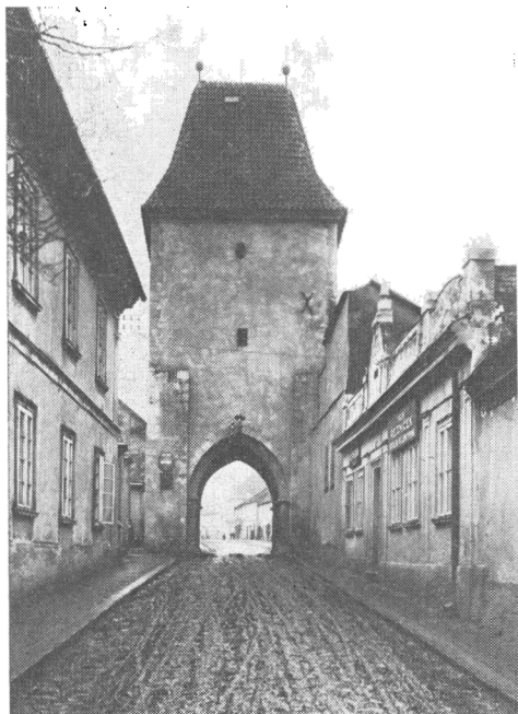
Obr. 10. Pražská brána od severu. Průčelní stěna (pravo) na bránu navazujícího domu je zřejmě původní zdi raně gotického předbrání. Foto z archivu ŠÚPPOP Praha, r. 1925.
