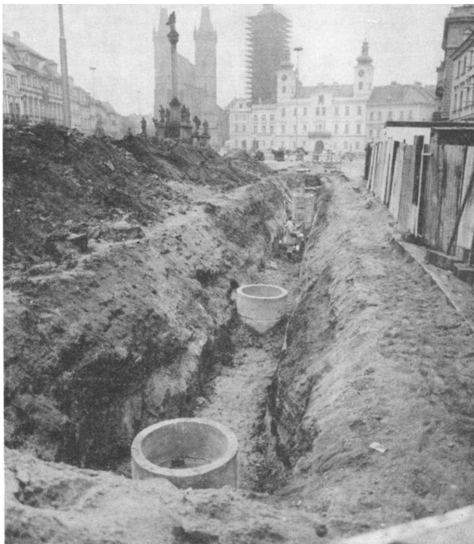
Obr. 1. Hradec Králové, Velké náměstí. Pohled na výkop pro kanalizaci od V (foto J. Beneš).
