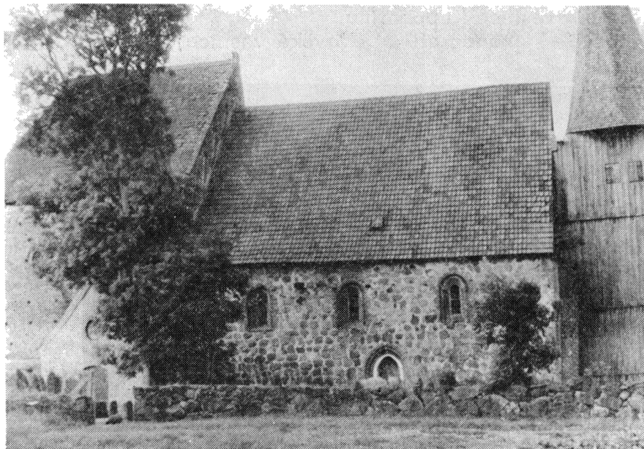
Obr. 2. Kostel v Kuppentínu (současný stav).
