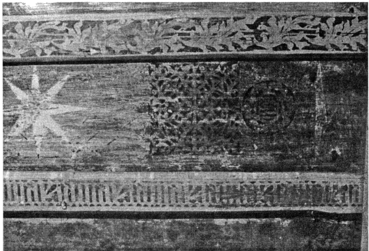
Obr. 4. Detail druhotně osazeného podbíjeného stropu z kostela sv. Vavřince ve Zdouni–Tedražicích (konec 15. století).
