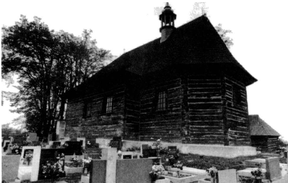
Obr. 1. Kostel sv. Mikuláše ve Velinách, dnešní stav.
