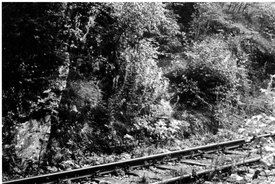
Obr. 17. Železniční trať Vimperk–Volary kříží Zlatou stezku nad Vimperkem. Foto P. Zavřel 1995.
