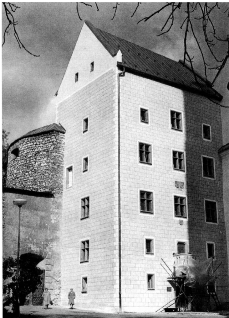
Obr. 2. Banská Bystrica, Lv. Matejov dom, rekonštrukcia červeného kvádrovania (k roku 1479).
