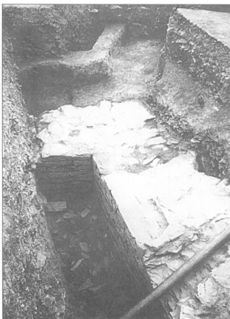
Obr. 9. Říčany hrad, okr. Praha-východ. Sondy 10, 12. a 15. Styk zdiva starší zahloubené části severozápadního křídla (v popředí) s negativem stěny části mladší. Foto T. Durdík.
