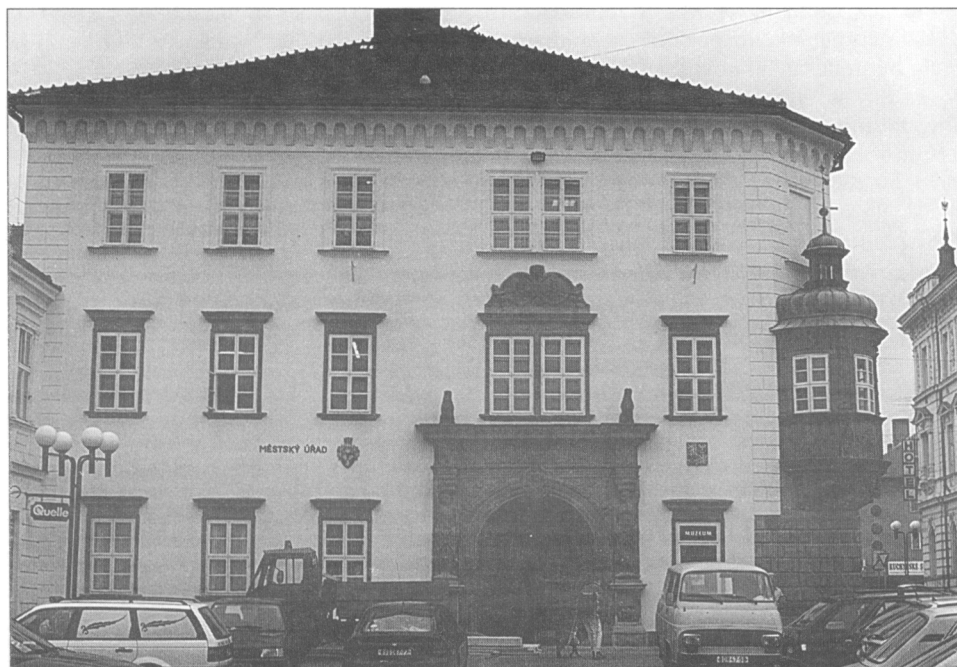
Obr. 3. Ivančice (okr. Brno-venkov). Východní průčelí domu č. p. 196 (tzv. domu panů z Lipé). Dnešní stav po přestavbě roku 1873 a dalších úpravách. Foto V. Karas, podzim 2001.
