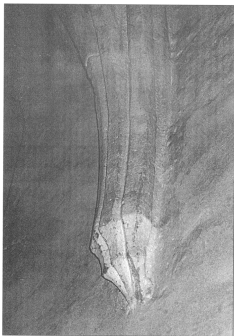
Obr. 11. Tečovice, kostel sv. Jakuba Většího – ostruhová klenební patka v presbytáři (foto: R. Vrla 2001).
