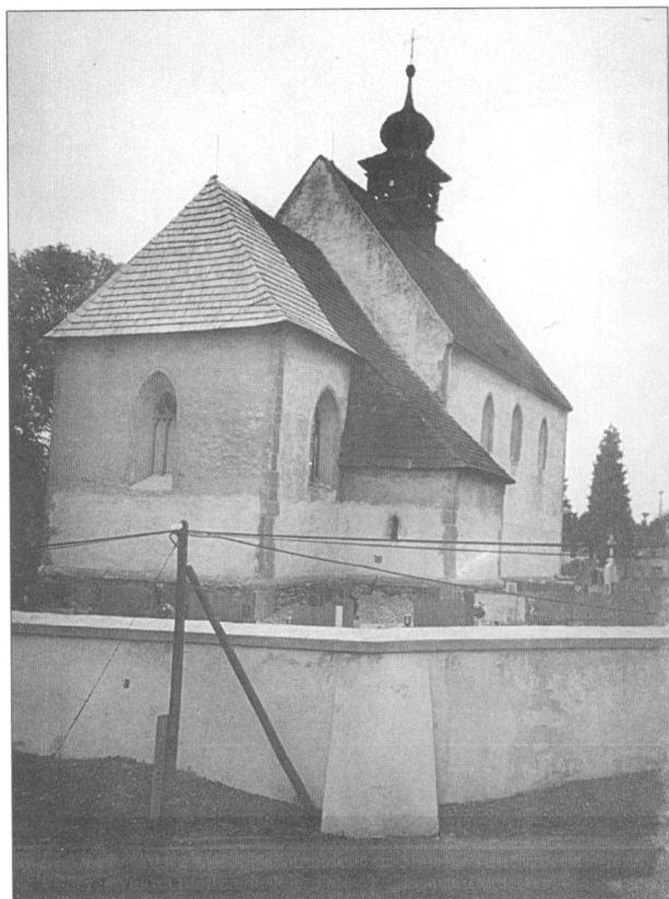
Obr. 10. Tečovice, kostel sv. Jakuba Většího – celkový pohled od severovýchodu (foto: R. Vrla 2001).
