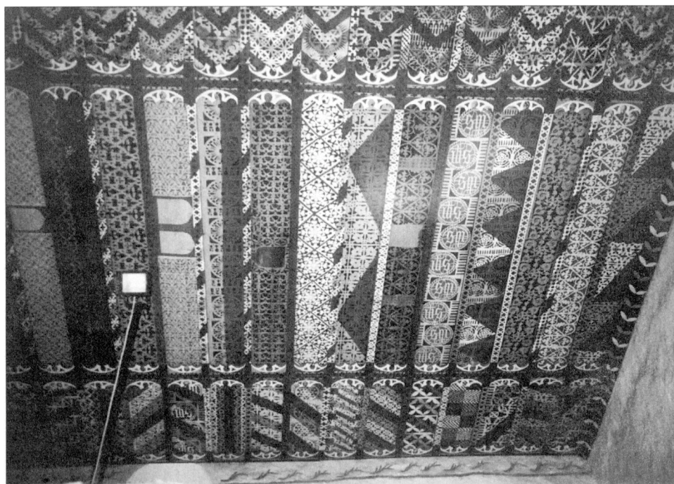
Obr. 10. Čerín, kostol sv. Martina, západná časť stropu.
