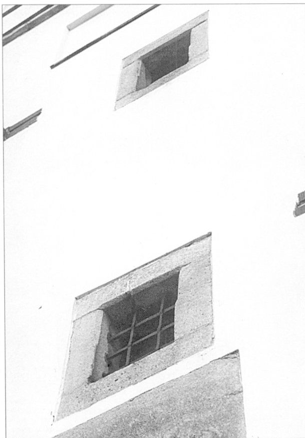
Obr. 3. Pozlovice – kostel sv. Martina; okénka s kamenným ostěním v západním průčelí věže.
