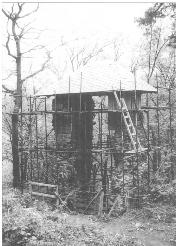
Obr. 5. Zlenice hrad, k. ú. Senohraby, okr. Praha-východ. Pohled z prostoru druhé brány na subtilní první branskou věž do jádra hradu v průběhu její rekonstrukce. Do tohoto prostoru stoupala severoseverovýchodním směrem přístupová komunikace. Foto T. Durdík.
