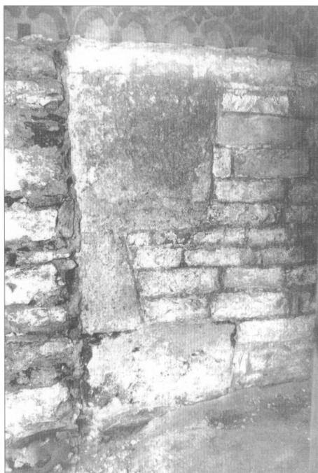
Obr. 5. Vrbno (okres Mělník), kostel Povýšení sv. Kříže. Západní hrana románské vnitřní špalety jižního portálu lodi armovaná pískovcovými kvádry. Vpravo navazuje románské kvádrkové zdivo. Vlevo pozdější (barokní?) zazdívka portálu.
