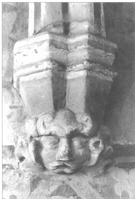
Obr. 8. Vrbo (okres Mělník), kostel Povýšení sv. Kříže. Klnební konzola na severní stěně presbyteria.
