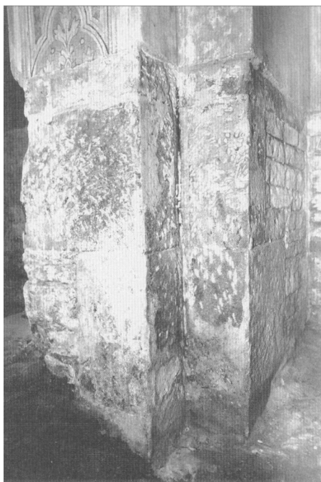
Obr. 4. Vrbno (okres Mělník), kostel Povýšení sv. Kříže. Jižní pilíř triumfálního oblouku s odkrytou kvádřovou armaturou. Vpravo je patrné románské kvádrkové zdivo východní stěny lodi. Vlevo je mezi kvádry zachováno několik kvádrků, které již nejspíše náležely vnitřnímu lici zdiva apsidy.
