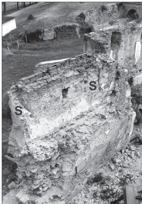
Obr. 4. Severozápadný pohľad na stojaci úsek západnej kurtíny s vyznačením polôh zamurovaných strielní (S). Foto M. Bóna VIII/98.
