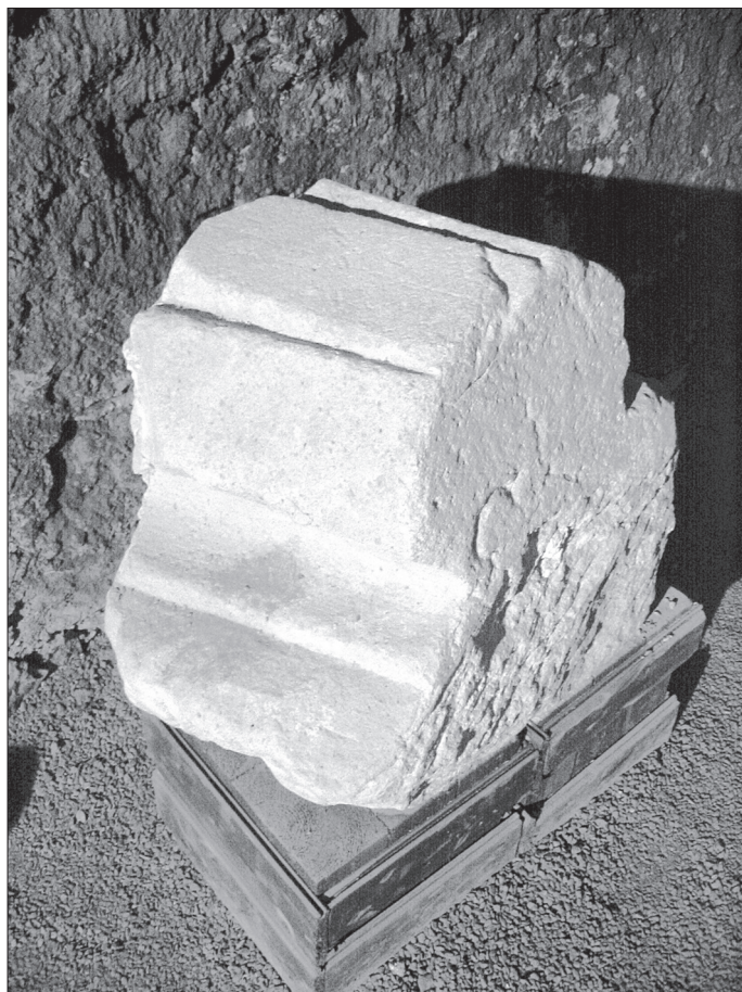
Obr. 11. Hrad Brumov; blok náběhu klenebních žeber. Foto R. Vrla 2006.
