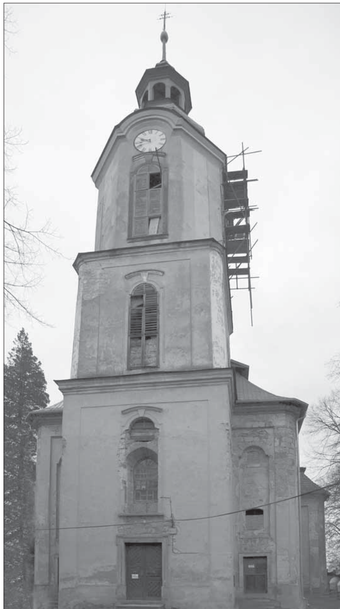
Obr. 4. Stráž pod Ralskem, kostel sv. Zikmunda. Celkový pohled na kostel od jihozápadu. Foto I. Peřina, 2007.
