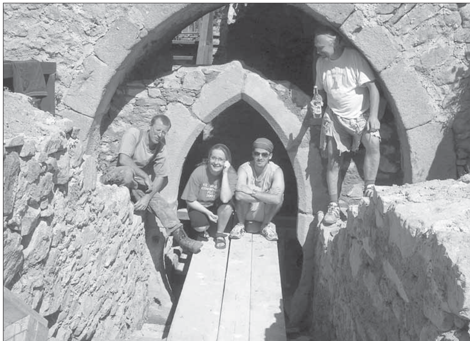
Obr. 4. Hrad Lukov. Znovuosazení portálu vestavěného na konci 15. století do vnitřní strany průjezdu zazděné raně gotické brány. Foto R. Vrla, 2007.
