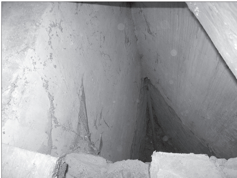
Obr. 5. Hrad Pernštejn; kout mezi pláštěm břitové věže (napravo) a severní stěnou objektu u břitové věže (nalevo), s plochami interiérových omítek.
