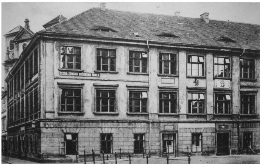
Fotografie staré školní budovy české školy ve městě Ústí nad Labem – ulice Solní (převzato ze Školní kroniky 1921/1935).
