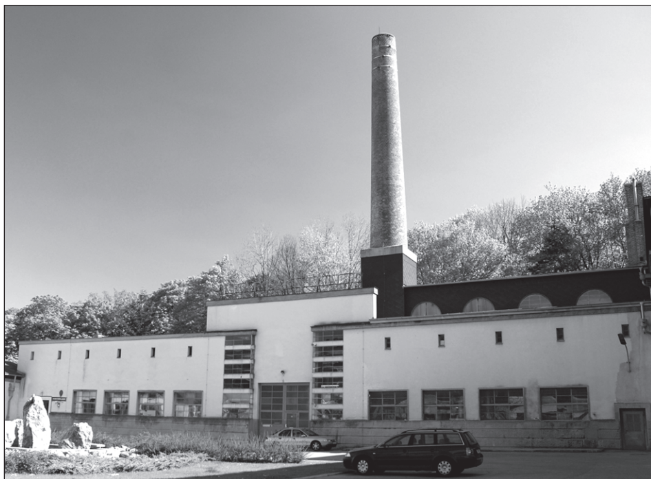
10. Karl Lehrmann, Budova energetické centrály v areálu Technického průmyslového spolkového vzdělávacího institutu, 1929
