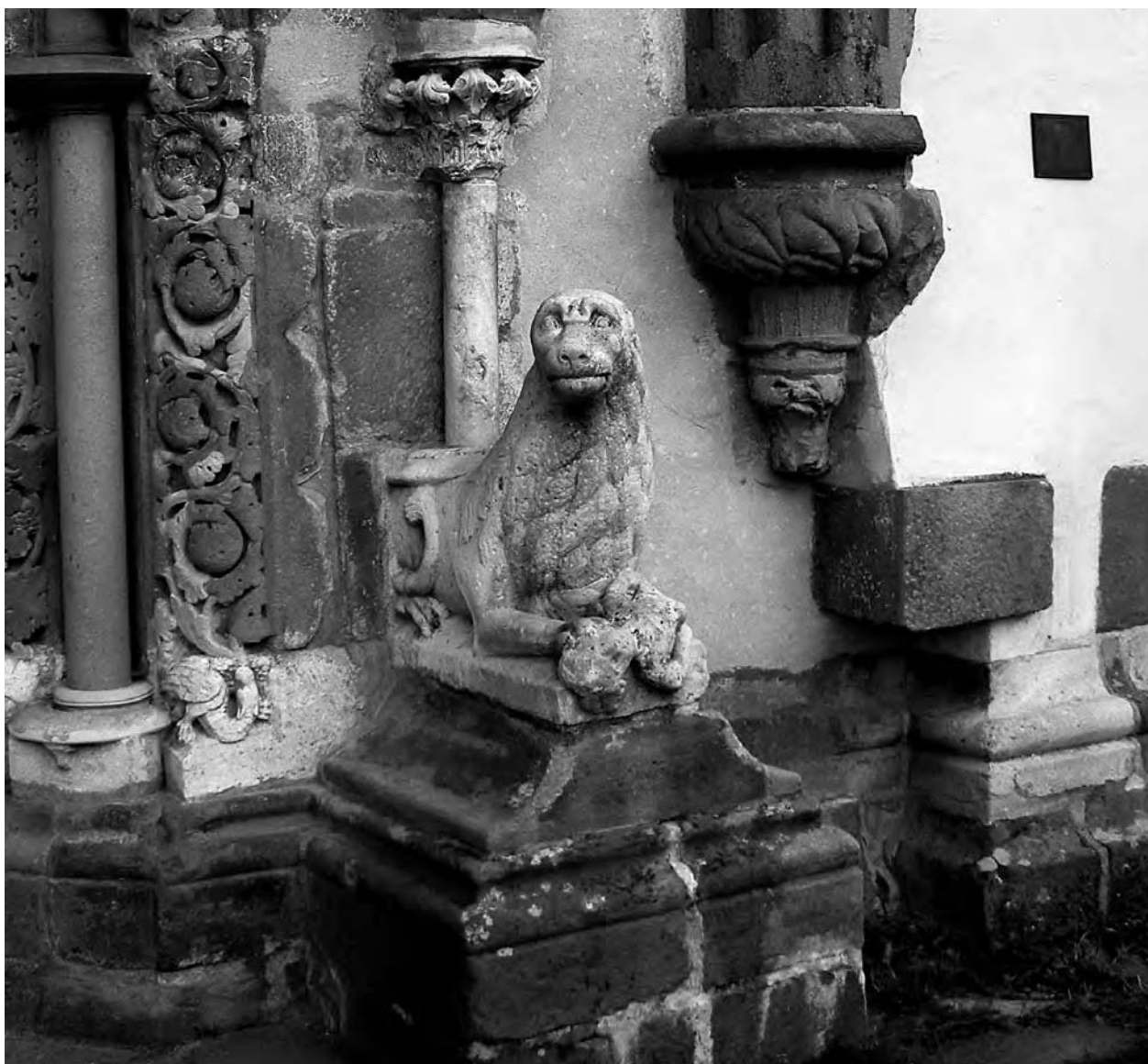
4 – Západní portál, jižní část s druhotně uplatněným článkem a kamenem vyrovnávajícím stavební chybu, před 1240. Předklášteří, klášter Porta coeli
