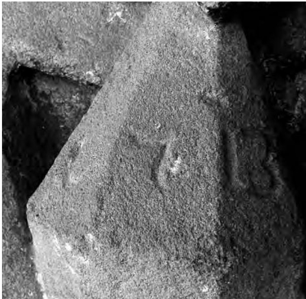
11 – Západní portál, tympanon, datum 1713 na střeše modelu kostela. Předklášteří, klášter Porta coeli
