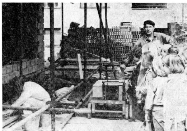
Obr. 81. Stavební práce a účast malých diváků
