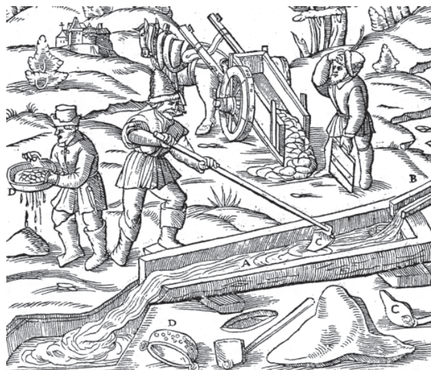
Obr. 17. Prádlo s umělým přívodem v dlabaných korytech, podle G. Agricoli, mědiryt 1556 (Ježek – Hummel 2001).
