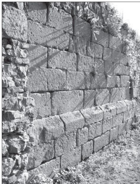
Obr. 1. Hrad Lukov, pohled od jihozápadu na jižní fasádu torza jižního pylonu. Foto R. Vrla, 2004.
