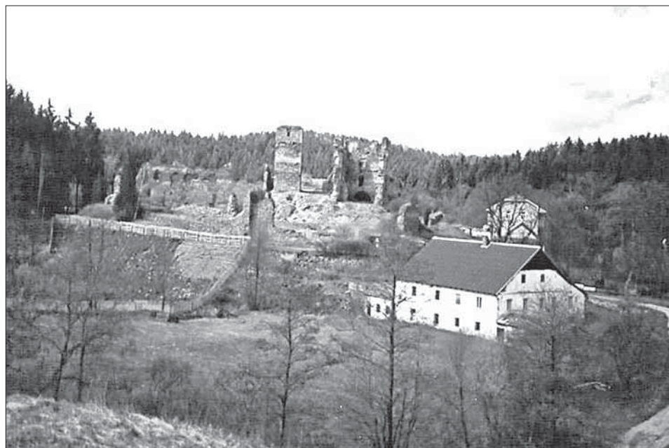
Obr. 3. Hrad Rokštejn, k. ú. Panská Lhota, město Brtnice. Celkový pohled na hrad od východu v roce 1999. Podle Měřinský-Plaček-Vlach 2009.
