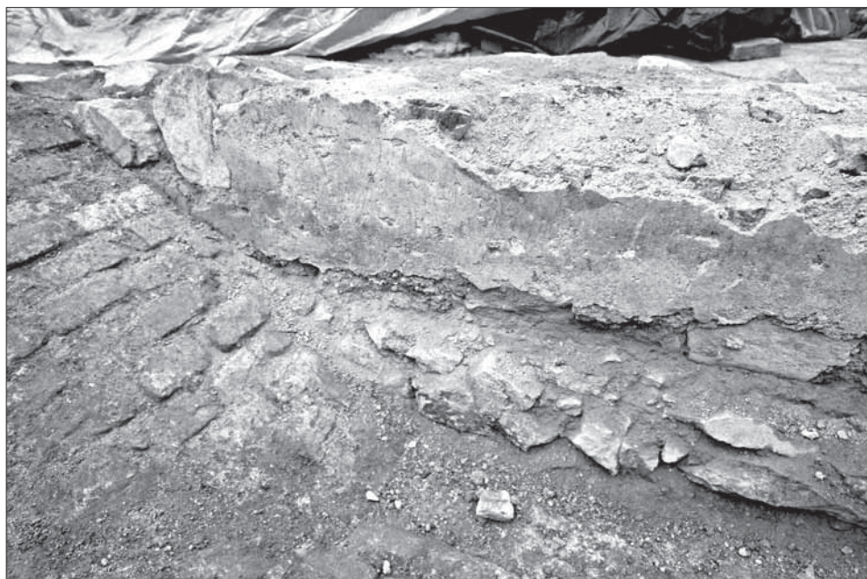
Obr. 9. Interiérové omítky přízemí zabíhající za čelo vložené klenby s. j. 8901. Foto archiv Archaia Brno, o. p. s. (inv. č. 14322-2008).
