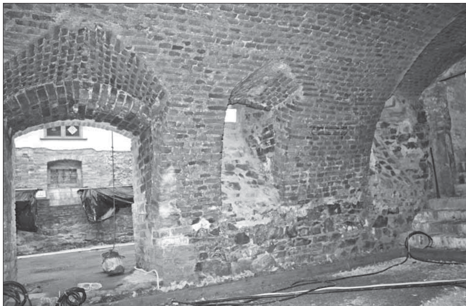
Obr. 6. Východní stěna objektu CO16 – Bednárný. Patrný původní vstup s. j. 8904 a dvě okna se strmým bankálem s. j. 8902 a 8917. Foto archiv Archaia Brno, o. p. s. (inv. č. 00579-2009).
