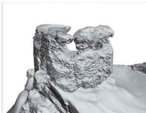
SEVEROZÁPADNÍ POHLED STÁVAJÍCÍ STAV
