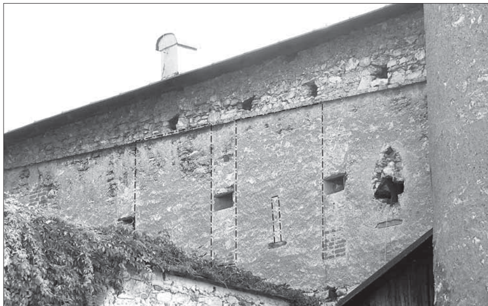
Obr. 3. Detail hradby zachovanej v štíte fary, mestský hrad v Banskej Bystrici. Bodkočiarkovane sú vyznačené zuby cimburia a štrbinová striedňa. Foto M. Miňo.
