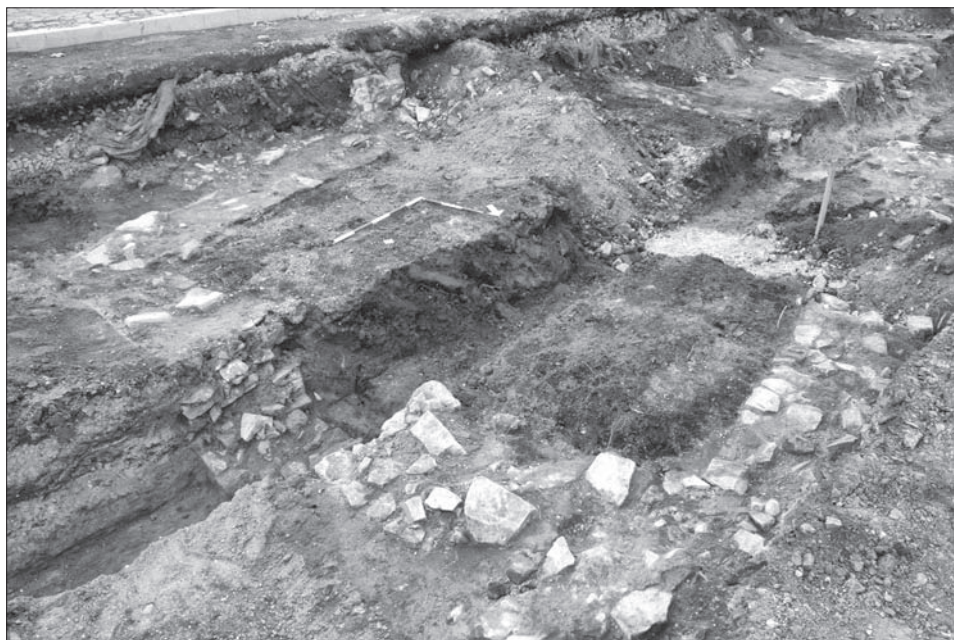
Obr. 5. Suterén dřevohliněného domu s. s. j. 13/10. Cihelnokamenné zdi náleží mladšímu domu s. s. j. 14. Pohled od severovýchodu. Fotoarchiv společnosti Archaia Brno, o. p. s.
