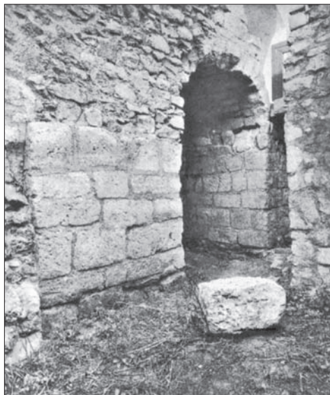
Obr. 5. Murivo Vodnej veže. Abb. 5. Mauerwerk des Wasserturmes.
