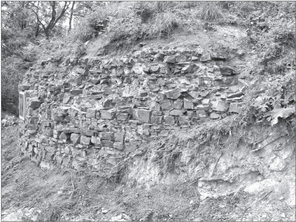
Obr. 6. Nezvěstice. Pohled na východní část obvodové zdi. Foto J. Bouda, 2007.
