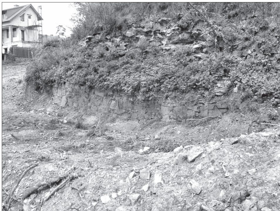
Obr. 9. Nezvěstice. Jihozápadní obvodová zeď, pohled od jihu, stav v roce 2008. Foto J. Bouda, 2008.
